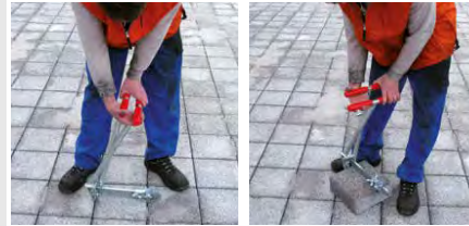
Ruční nosič betonové dlažby
